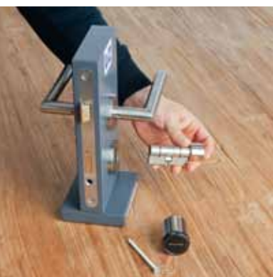
Zylinder in PZ-Lochung einschieben
